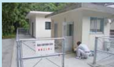
水道水を毎月全ての浄水場から採取します。(写真は飯美地区浄水場)
